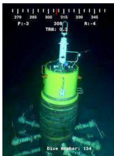
Figura 4.14 - Exemplo de uma cabeça de furo offshore (Fonte: www.offshore-energy.biz/universal-subsea-installs-defender-on-talos-subsea-well/ ).
